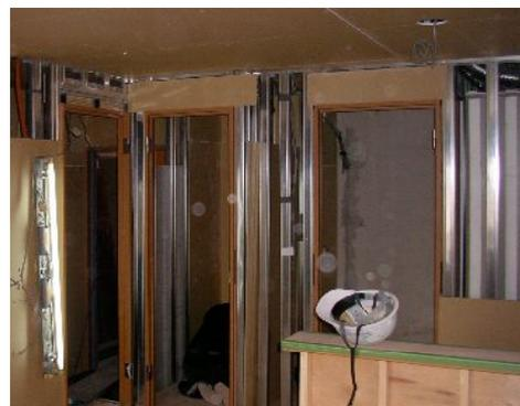
新たな部屋の骨格となる軽量鉄骨が組み、ボードが張られていきます。
